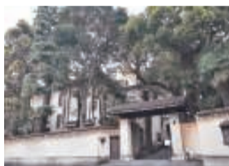
地下1階・地上3階、約300㎡の延床面積をもつ。オープンガーデンは500㎡。耐震構造の父と呼ばれ、東京タワーの構造設計者の内藤多伸氏の設計
