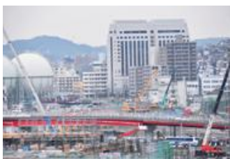
交流拠点施設建設予定地周辺の様子
