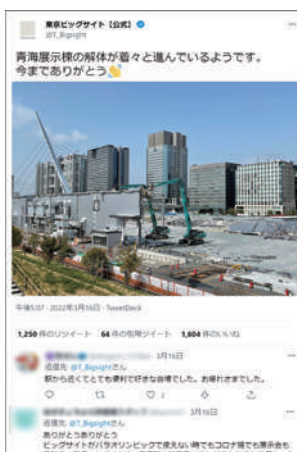
解体工事のようすを紹介した投稿(東京ビッグサイト公式Twitterより)
