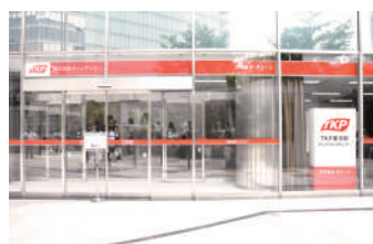
「新横町ビル」エントランス。1Fにも大小4室を増床
